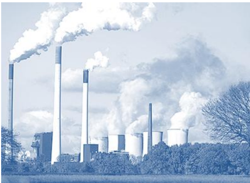
图为位于德国盖尔森基兴的一处燃煤发电厂。
