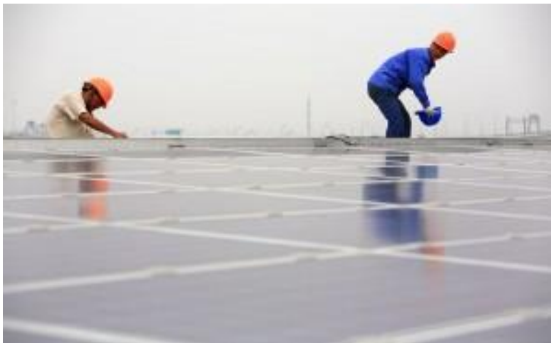
安装太阳能板，上海虹桥。图片版权：Jiri Rezac/The Climate Group
